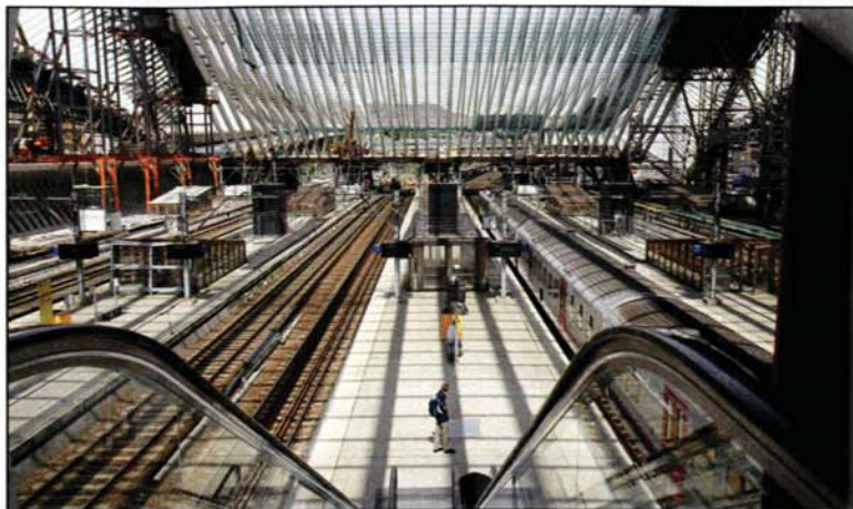
Het nieuwe tgv-station in Luik: 'Onze kostenraming was zo'n twee miljard frank. Met Calatrava zaten ze al gauw aan 4 miljard, en ondertussen gaat het naar het dubbele. Of is het nu al negen miljard?'
