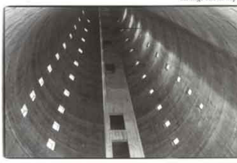
Het onderste gedeelte van de schacht, voor de montage van de trap.
