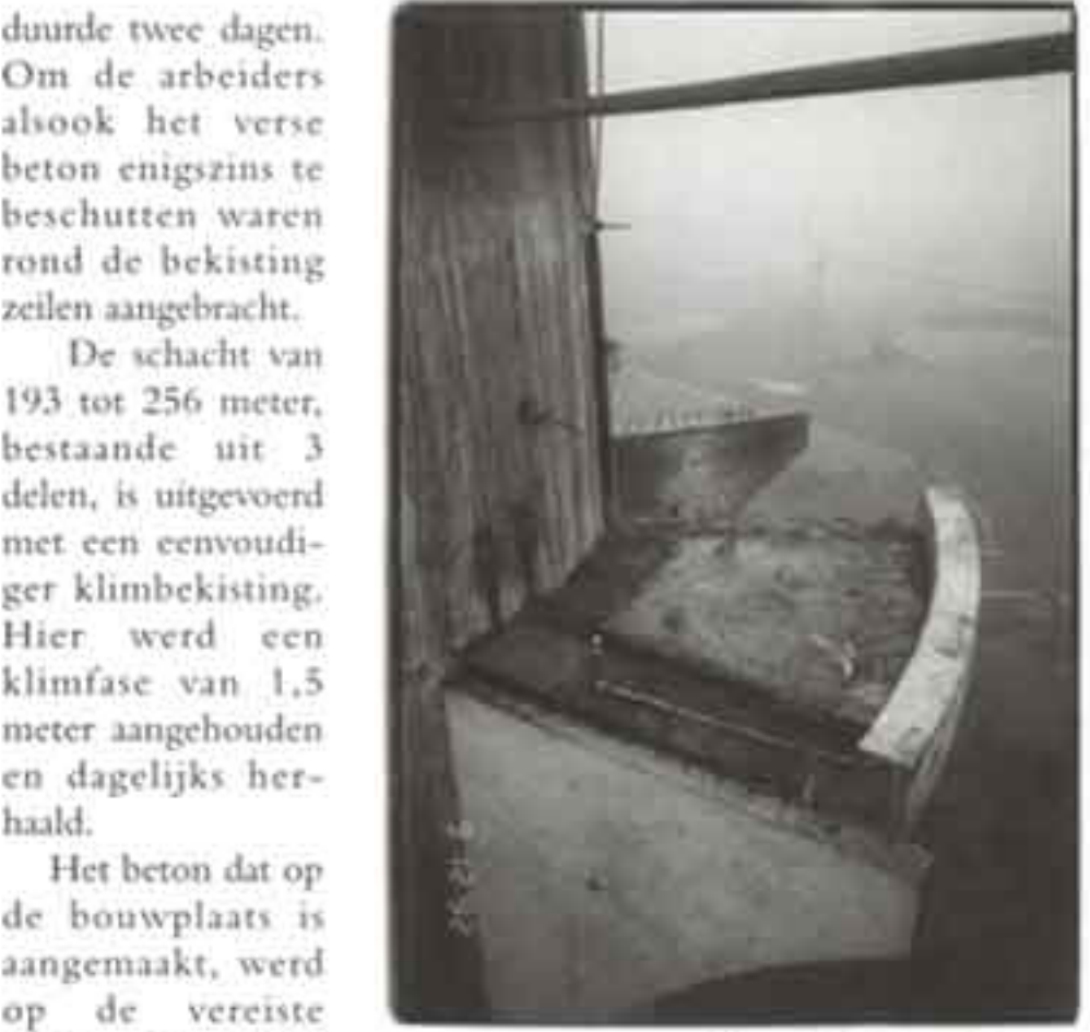
De gedetailleerde montage van het platform op 74 meter.
