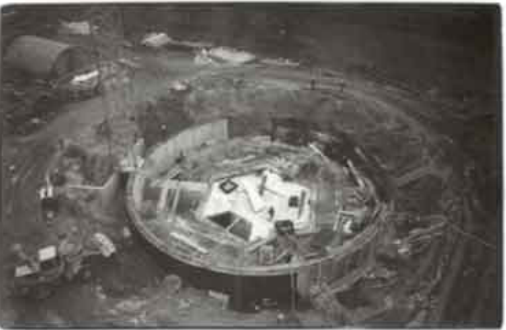
De ondergrondse aanvoer van de buitenmantel van de mast rond de fundering van de centrale liftkoker.
