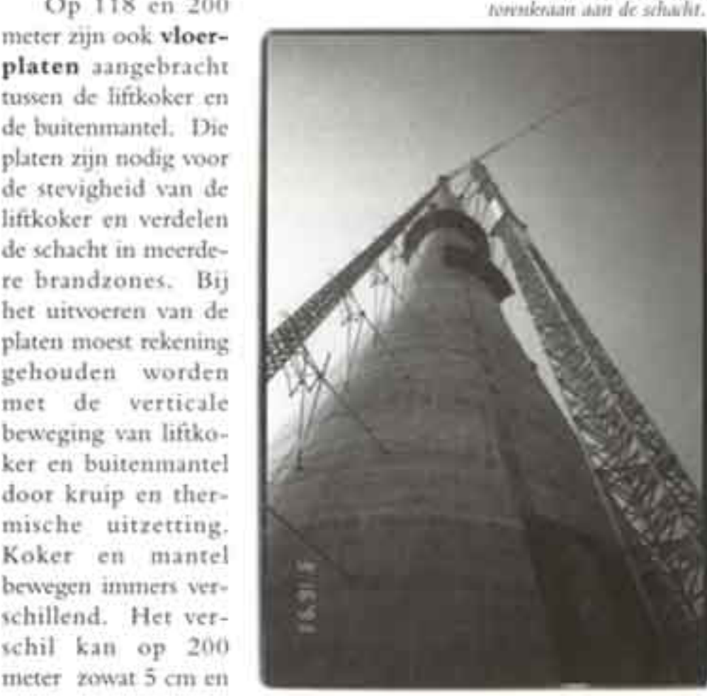
De bevestiging van de bouwlijst flikker en torenbuis aan de schacht.
