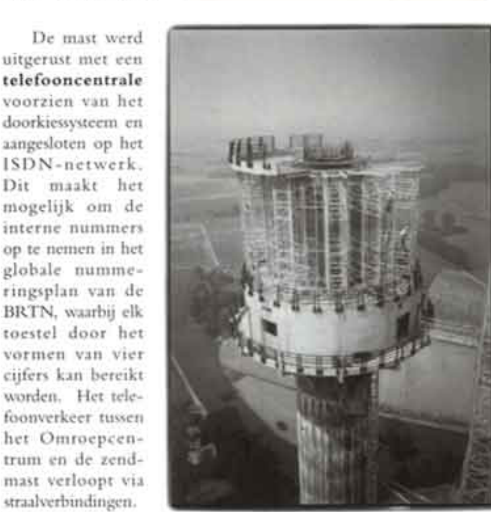
De montage van de prefab-flikker en het platform op 207 meters.
